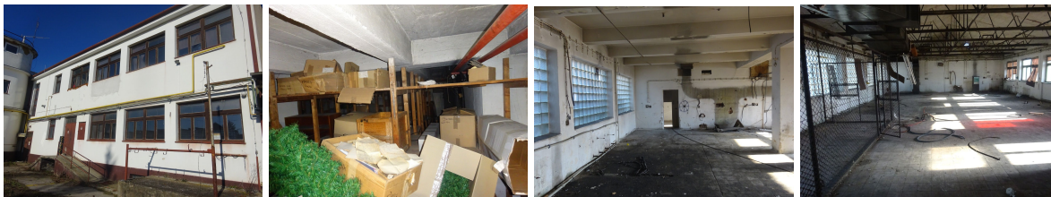
Obr. 8. - 11.: Budova dielne, exteriér a interiér
