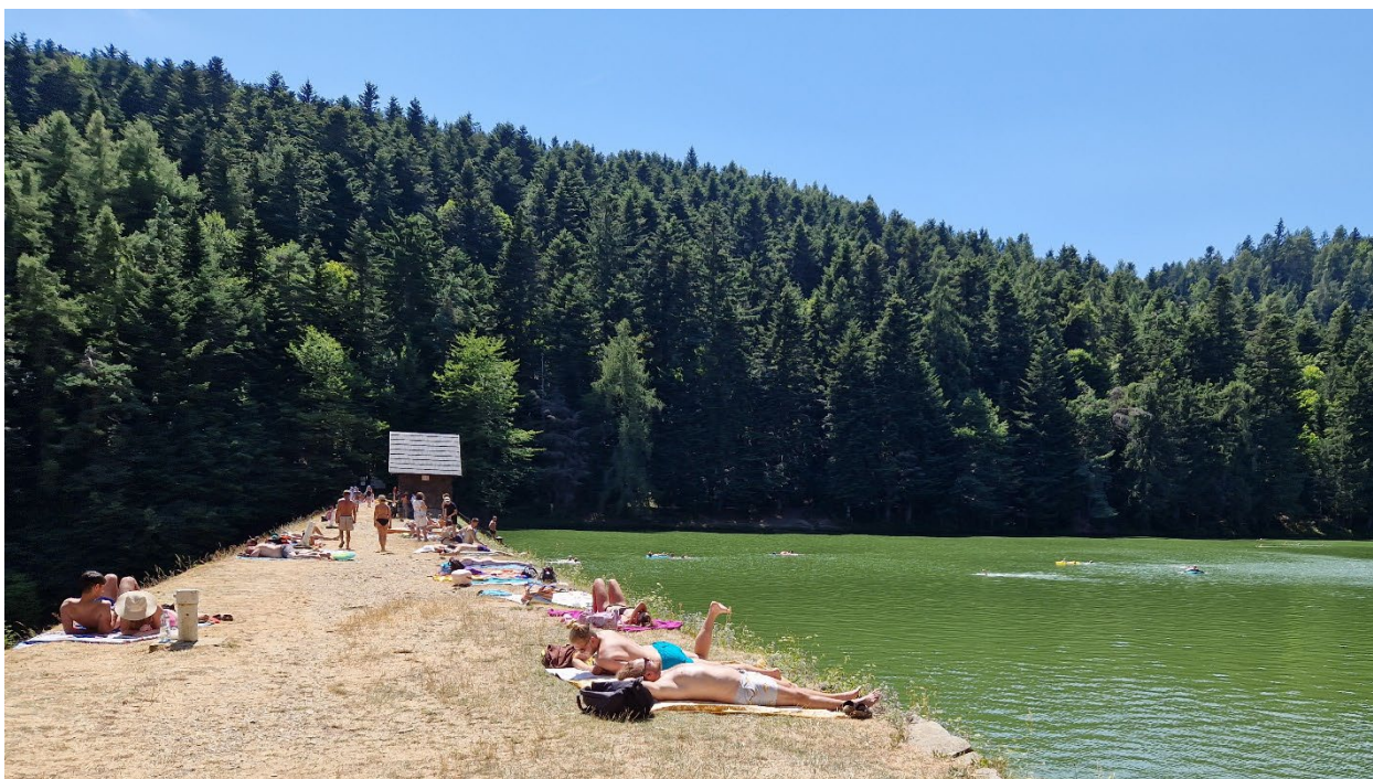
Tajch Klinger: trávnatý kryt hrádze je ponechaný na samovývoj, už v polovici leta je zdegradovaný suchom, intenzívnym pohybom a pobytom rekreantov. Hrozí erózia pôdy a poškodenie hrádze.
