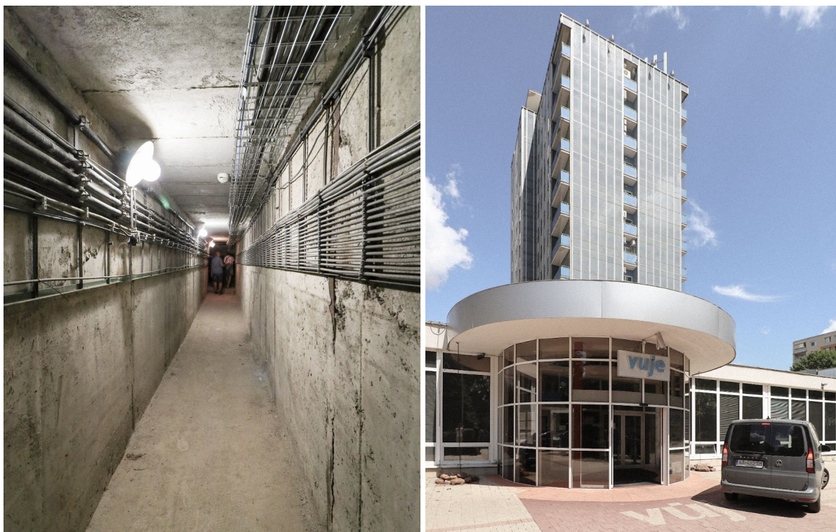
Obr.8: Fotografie podzemnej servisnej chodby a hlavného vstupu do objektu v bloku C
