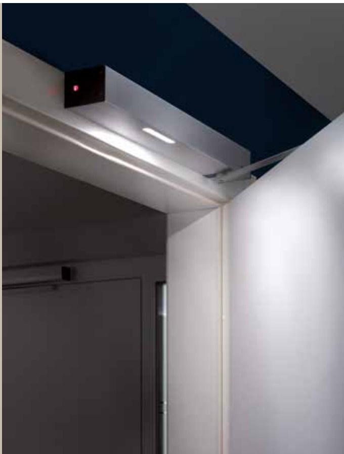
Integrované osvetlenie sa stará o orientáciu a optimálne osvetľuje oblasť prechodu dverí.
